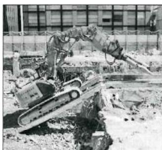
大型クレーンが設置できない現場でも、CROSS-BEAMにより1階からR階へ重機が自走して登ることができる新工法で特許を取得しています。また、荷重試験による検証で安全性を確認しています。
